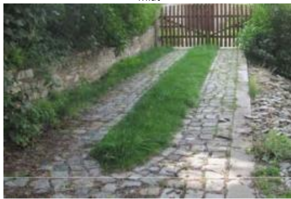
Zpevněné pásy v rozteči kol automobilu
