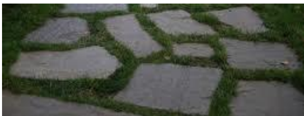
Kamenná dlažba před kapličkou
