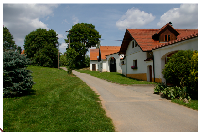
Nevyhovující nadzemní vedení
